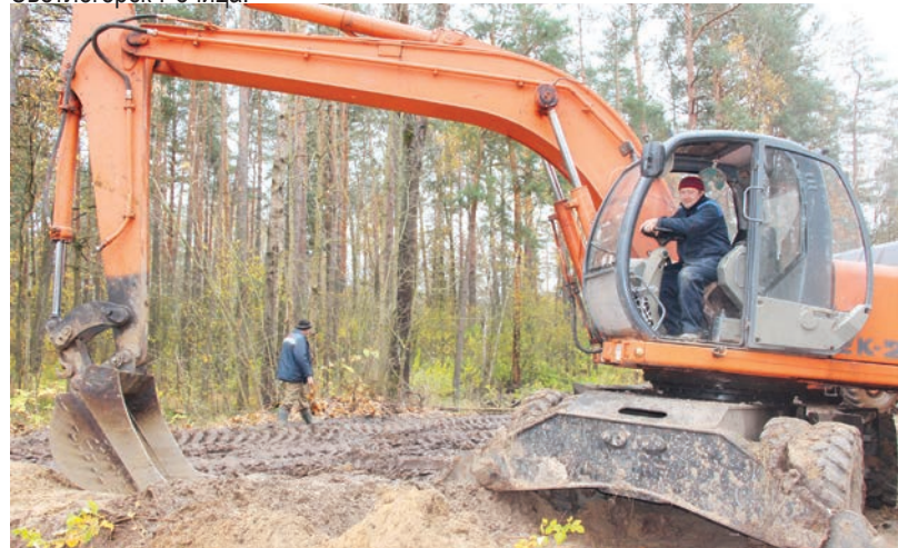
Машинист экскаватора цеха ВКНиОСВ Олег ИСАКОВ за работой.
