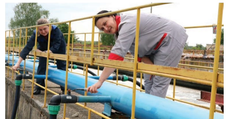
И.о. инженера-технолога ОСВ Ольга АРТЮШЕНКО и бригадир аппаратчиков очистки сточных вод 4 разряда Наталья ХАЙНЮК рассказывают, что сточные воды поступают в аэротенк после механической очистки. Для обеспечения нормального процесса биохимической очистки в аэротенки необходимо непрерывно подавать воздух.
