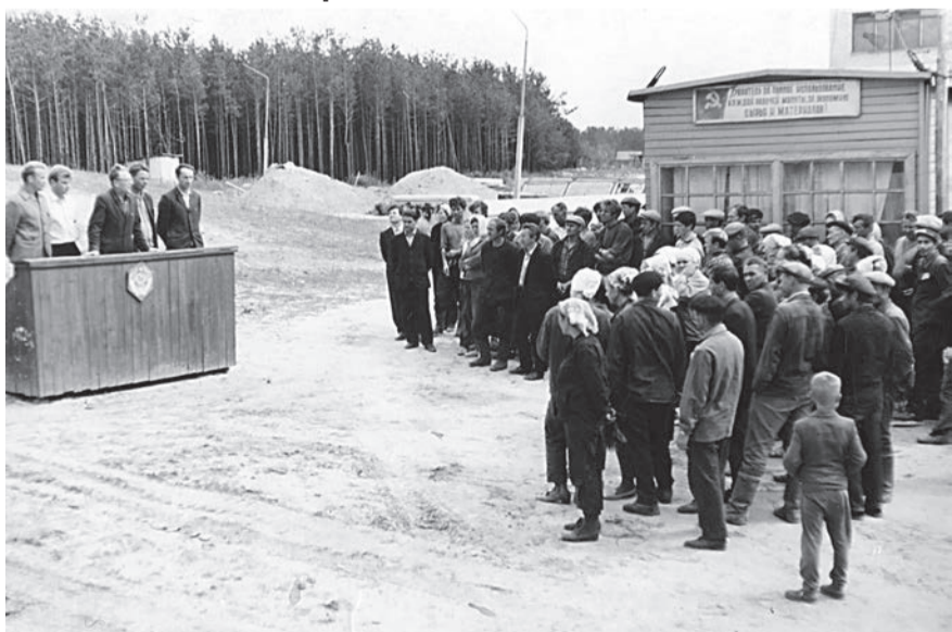
Строительство заводской трубы. 1964 год.
